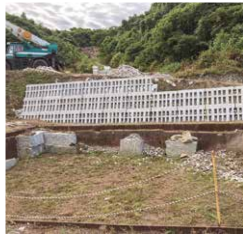
ガンロック施工現場
